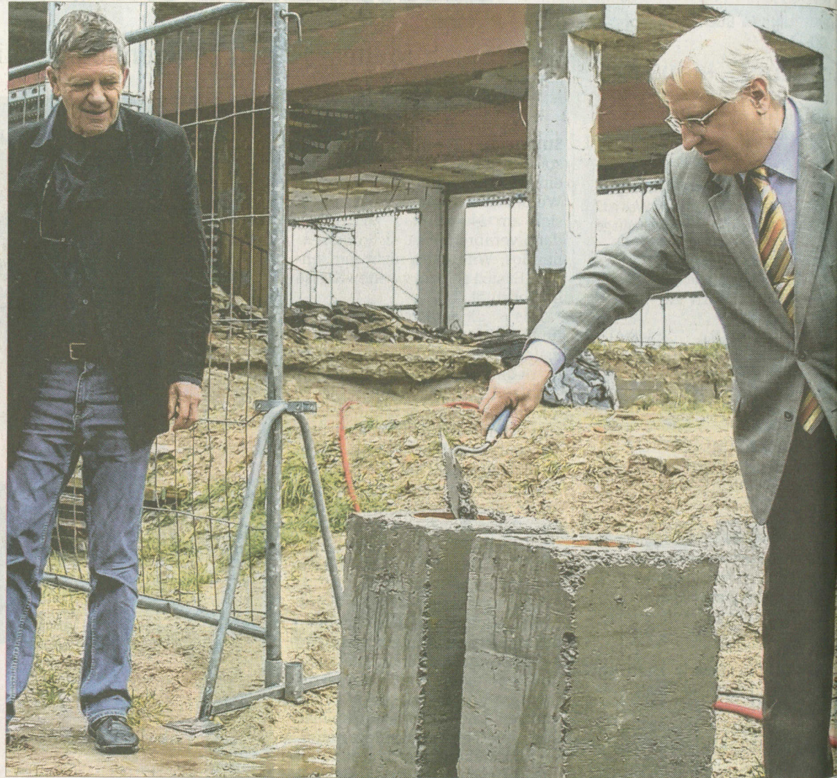
Baabes Bürgermeister Dieter Mathis (r.) und Architekt Carsten Gieseke legten gestern den Grundstein für das „Haus Meeresblick“ und das „Inselparadies“, das entkernt im Hintergrund zu sehen ist.
